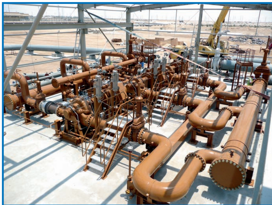
■ Бустерная станция для разгрузки танкеров
